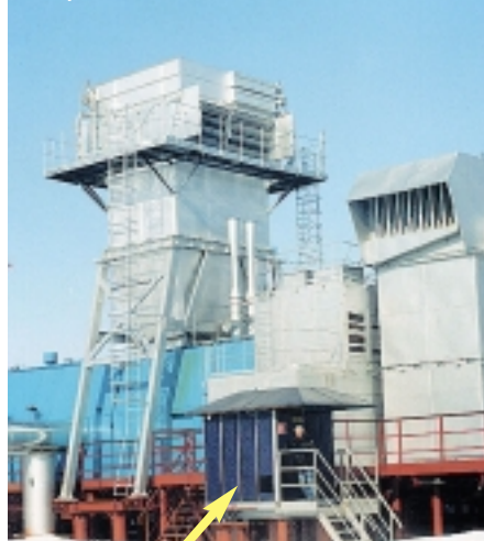
Блок-бокс с аппаратурой САУ размером (2х2х2) м
